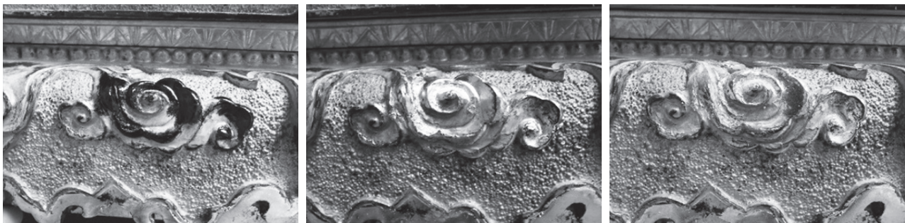
写真 14 台座の漆剥落部分（左：漆を塗布、中：金箔を押す、右：古色仕上げ）
