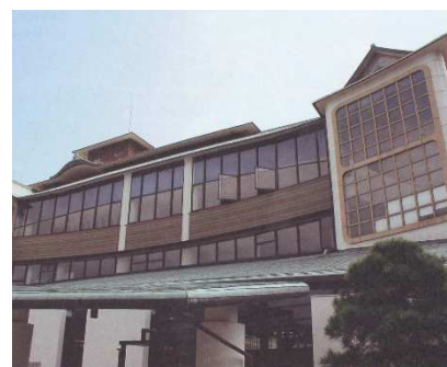
図 1-4. 直島町役場の窓
