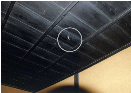
八畳間（奥中の間）天井 蛭釘が残っている（○印）
